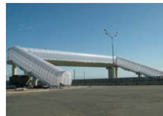
2008 год, Санкт-Петербург. Строительство Комплекса Защитных Сооружений от наводнений. Гидроизоляция напорной грани дамбы MasterSeal 588 Grey, защита жб поверхностей пешеходных переходов MasterProtect 330 EI RAL 1013, пролетных конструкций и опор путепроводов MasterSeal 588 RAL 7044.
