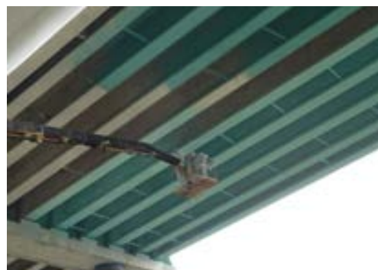
2014 год, Ярославль. Капитальный ремонт Октябрьского моста. Защитная декоративная окраска жб конструкций MasterProtect 330 EI RAL 6027
