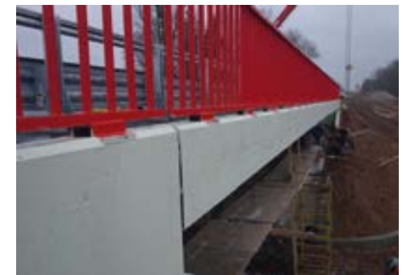
2013 г. Мост через реку Зарезница на км 301+469 автомобильной дороги М-20 Санкт-Петербург–Псков–Пустошка–Невель до границы с Республикой Беларусь, Псковская область. Защитное покрытие MasterProtect 330 EI
