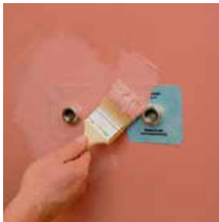
Защита вывода трубы с помощью ленты MasterTile WP 620/630
