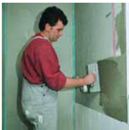
После высыхания гидроизоляции поверхность готова для укладки плитки.
