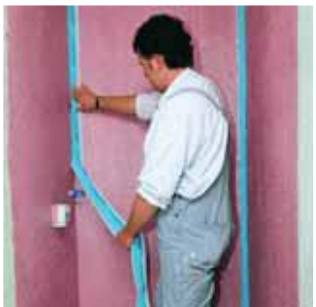
Защита углов с помощью MasterTile WP 620/630
