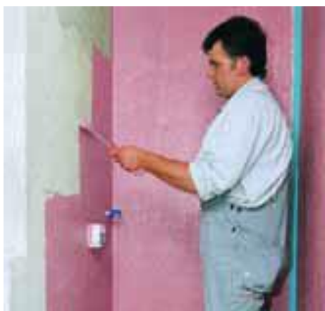
Нанесение первого слоя красной гидроизоляции MasterTile WP668.
