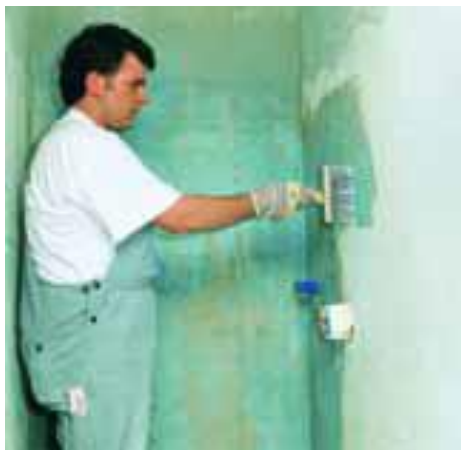
Нанесение грунтовки MasterTile P302 на непитывающие и гипсовые основания.
