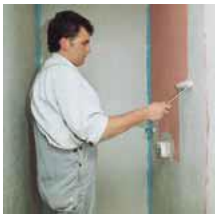
После высыхания первого слоя гидроизоляции нанесите второй слой серого цвета. Предыдущий слой не должен быть виден.
